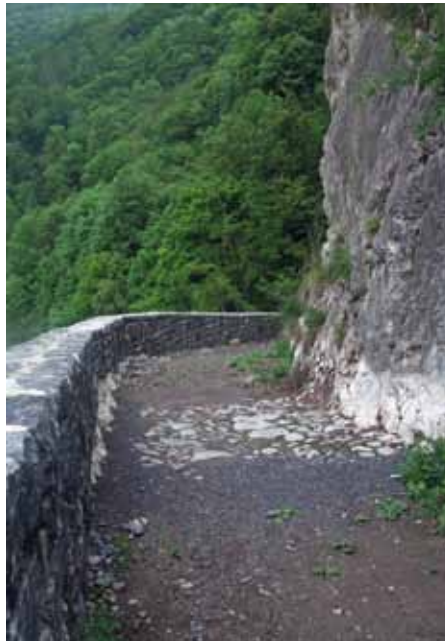
Die Strasse am Ausgang der Hohwand mit dem archäologischen Fenster. Bild Maja Widmer, Sargans
