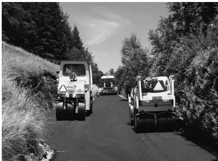
Sanierung Alpenstrasse mit Ausweichstelle
