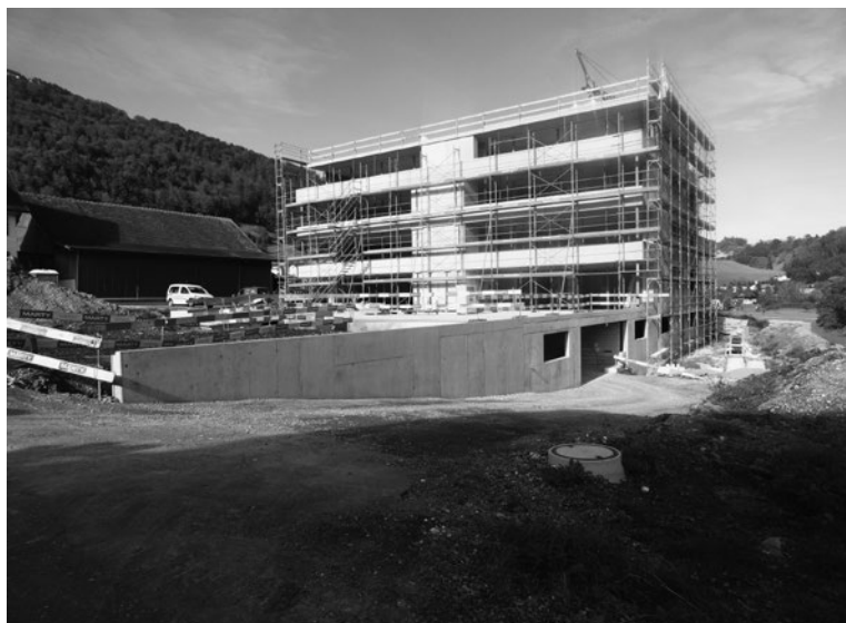
Rohbau MFH-Feldgass, Azmoos
