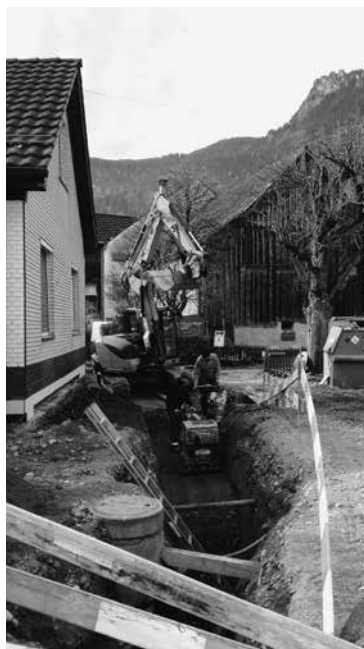
Strassenbau auf engem Raum
