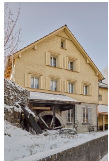
Fassadensanierung alte Schmiede, Oberschan (Bild: Peter Schulthess, photoimage)
