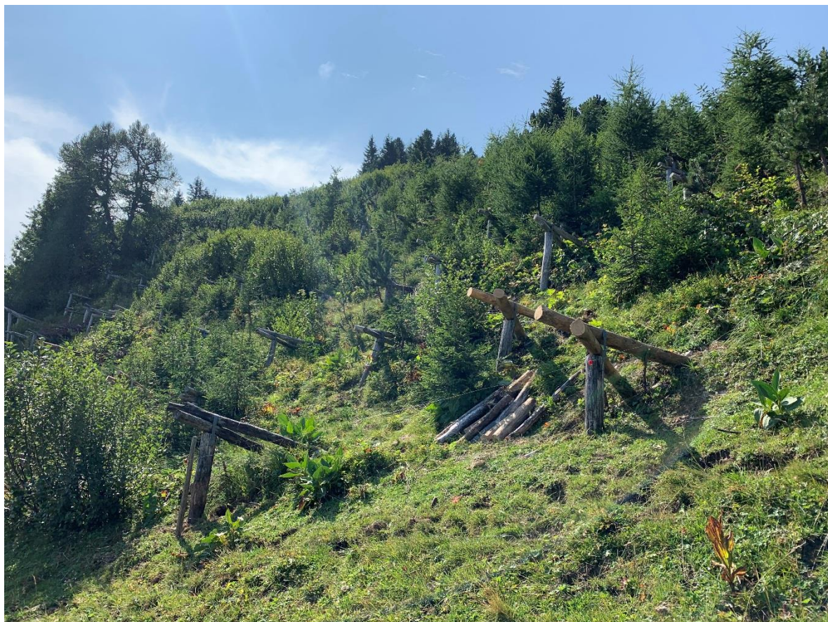
Lawinen- und Aufforstungsprojekt Gonzen Zu sehen sind sowohl reparierte als auch alte Dreibeinböcke.
