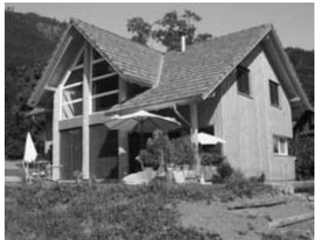
EFH in Oberschan; Konstruktion: Holzrahmenbau; Fassade: Hinterlüftete Holzfassade, unbehandelt; Speziell: Holz aus den Wartauer Waldungen
