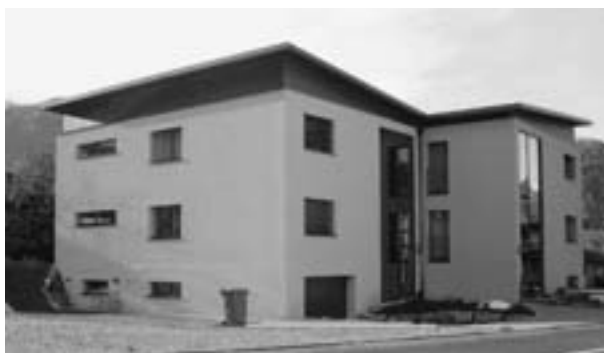
Mehrfamilienhaus in Balzers; Konstruktion: Holzrahmenbau; Fassade: Kompaktfassade, verputzt; Speziell: Hochwärme gedämmt
