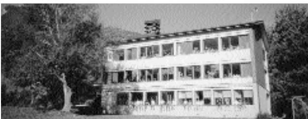
Am 20. Oktober 1963 wurde das neue Schulhaus eingeweiht.
