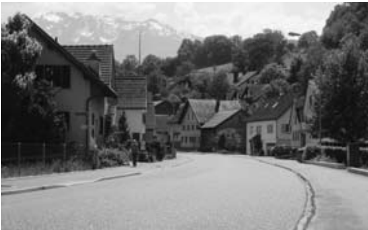
Autofreies Weite nach Belagseinbau
