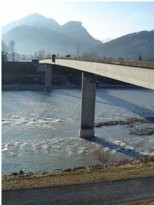
Pfeilersanierung Fuss- und Radwegbrücke Trübbach-Mäls (Balzers)
