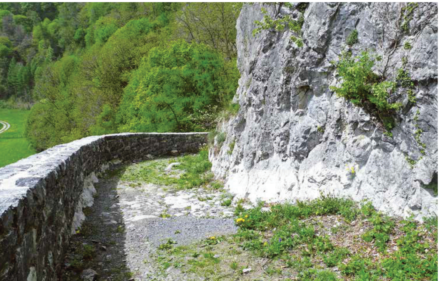
Strassenstück in der Hohwand mit freigelegter Pflästerung
