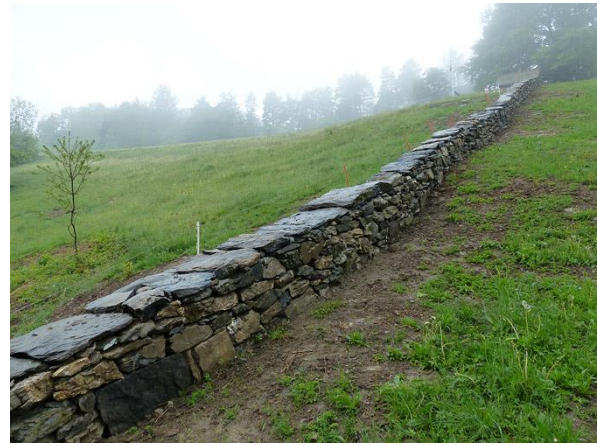
... nach der Sanierung wieder eine ansehnliche Weidema- mauer. Die Weidetiere werden jeweils mit einem Zaun von der Mauer ferngehalten (weisser Pfosten).
