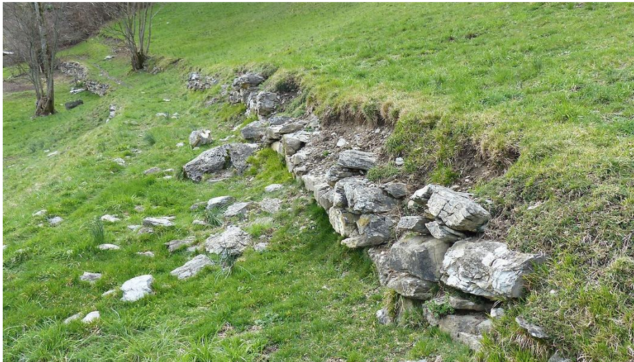
Ostteil der Mauer 207, vor ...
