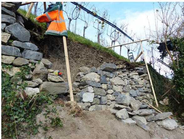
Mauer 170, Burghalde: Während der Arbeiten ...
