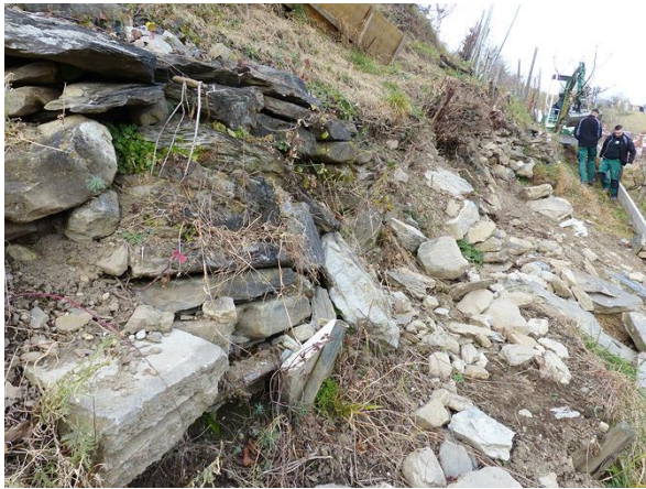
Mauer 59, Rössliwingert: Zustand bei Baubeginn ...
