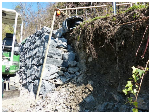
... und die Mauersanierung in Arbeit.
