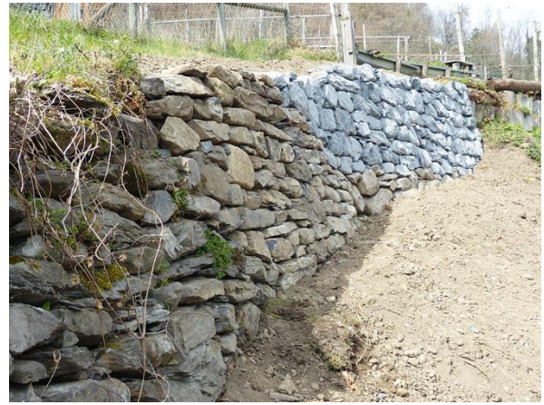
... und wieder als stabile Mauer instandgestellt.
