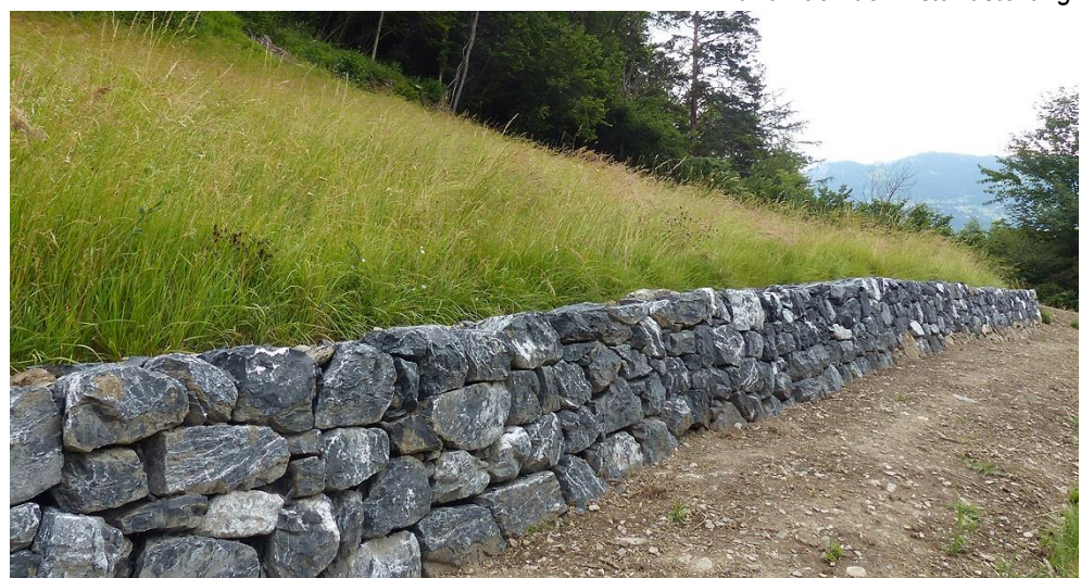
... und nach der Instandstellung.
