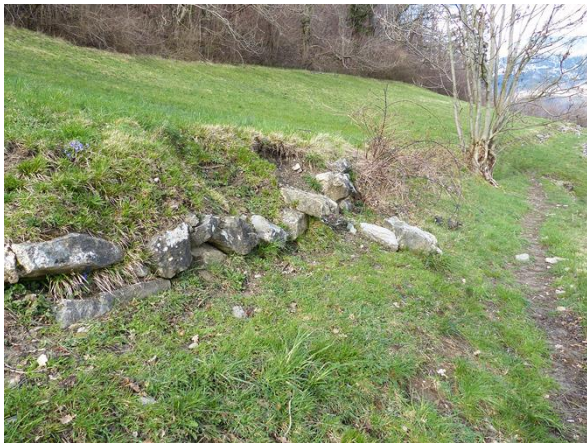
Mauer 207 (Westteil), Vergolis: Zerfallene Strecke ...
