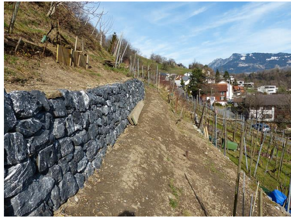
... und nach der Instandstellung (rechts Azmoos).
