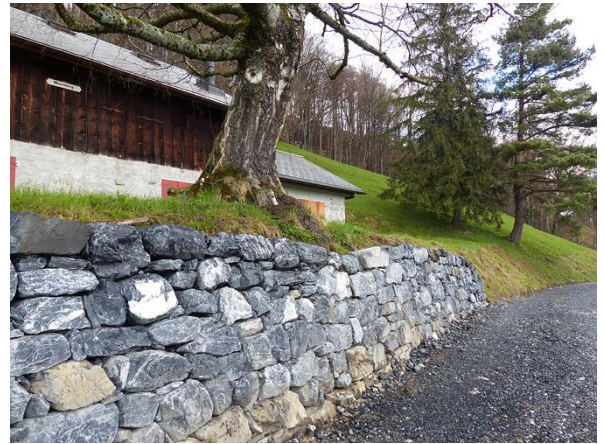
... nach der Sanierung wieder eine schöne Mauer.
