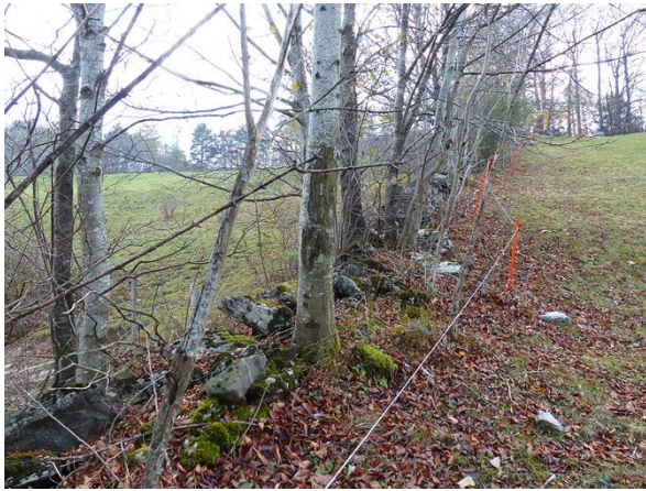
Mauer 212, Selva oben: Zuvor ein bestockter Steinwall, ...
