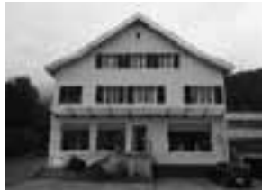
Nach der Renovation.
