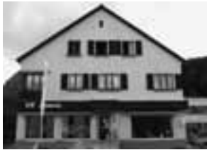
Vor der Renovation.
