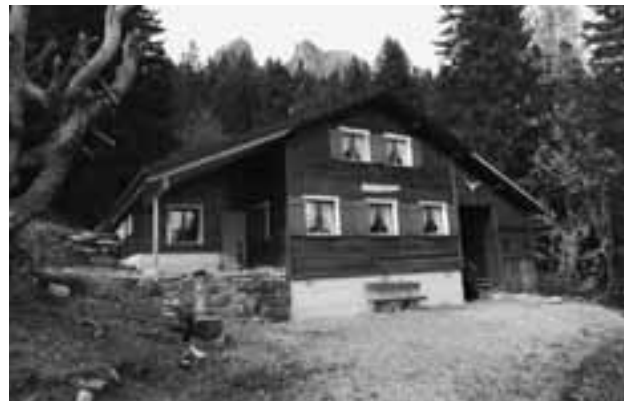
Ansicht des Skihauses nach Anbau vor Abbruch der Nordseite.
