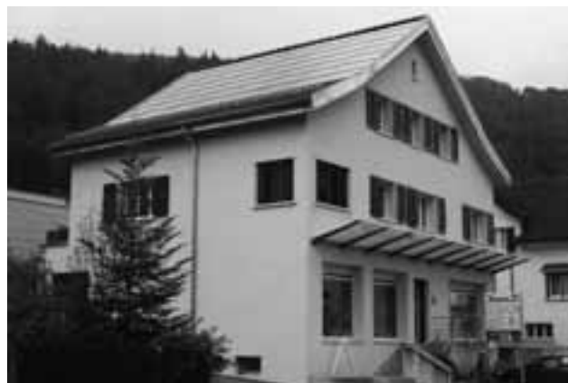
EW Ladengebäude mit integrierter Photovoltaikanlage System 3-S auf der südlichen Dachfläche (Panelfläche: 62 m 2 ; installierte Leistung 8,15 kWp).
