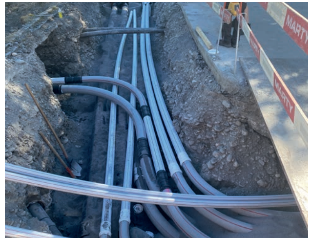
Leitungsbau in Trübbach
