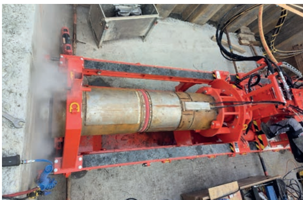
Pressbohrung beim Trübbach
