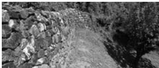
Dieselbe Mauer nach der Instandstellung.
