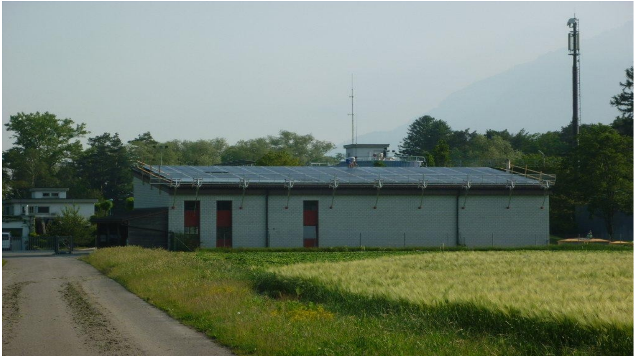
Photovoltaikanlage Gemeinde-Werkhof, Araweg 2, Weite Die Montage der Module ist beinahe abgeschlossen.
