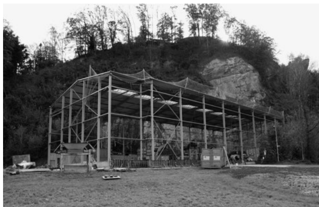
In Plattis entstand in den letzten Wochen eine komplett neue Halle.
