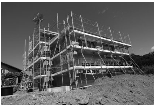
EFH-Rohbau Unterer Fallweg, Oberschan
