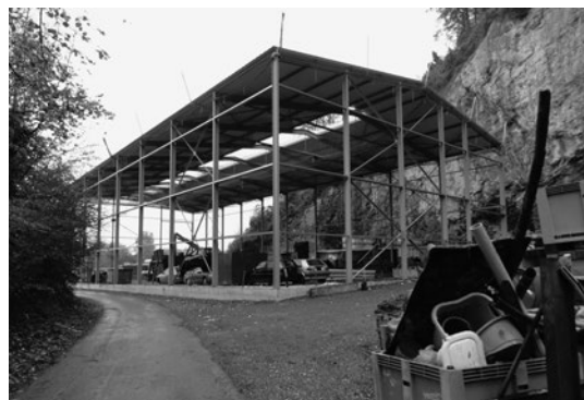
Werkhalle Autoverwertung Pfiffner, Plattis
