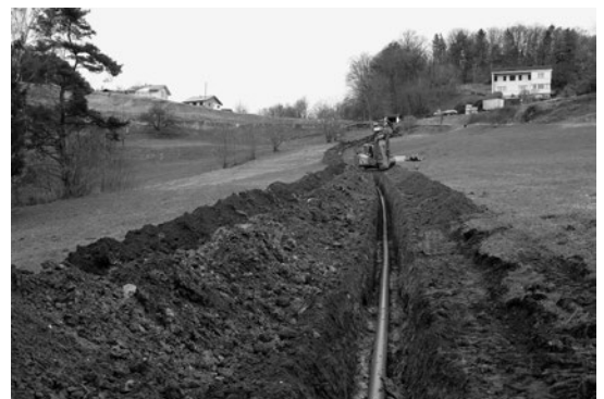
Kanalisation Unterer Fallweg – Tobel
