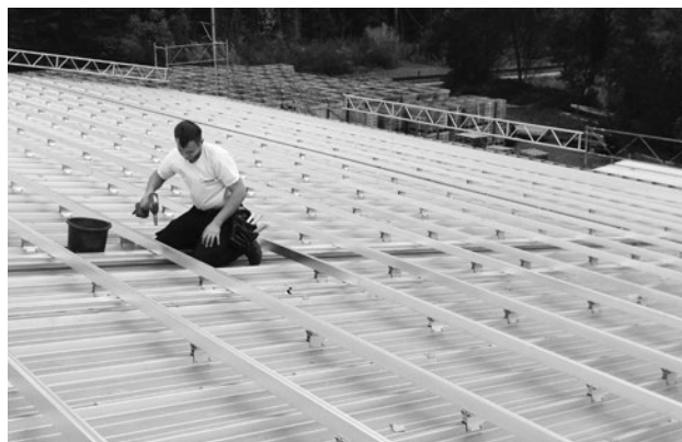
Die Arbeiten auf den Dächern in Plattis sind in vollem Gange.
