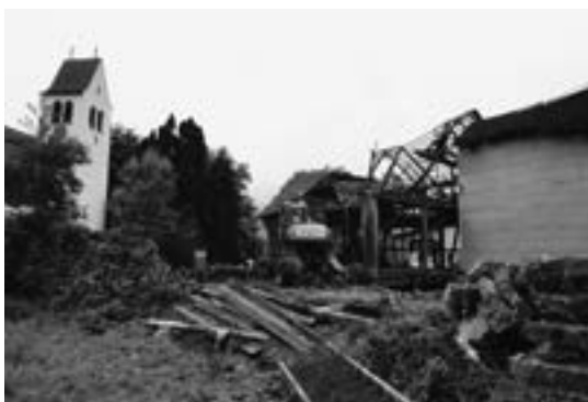
Abbruch für Wohnhausneubau, Gretschins
