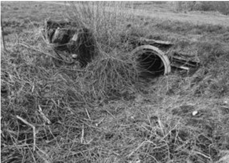
Dieser Giessen samt Durchlass ist bereit für das Wasser.
