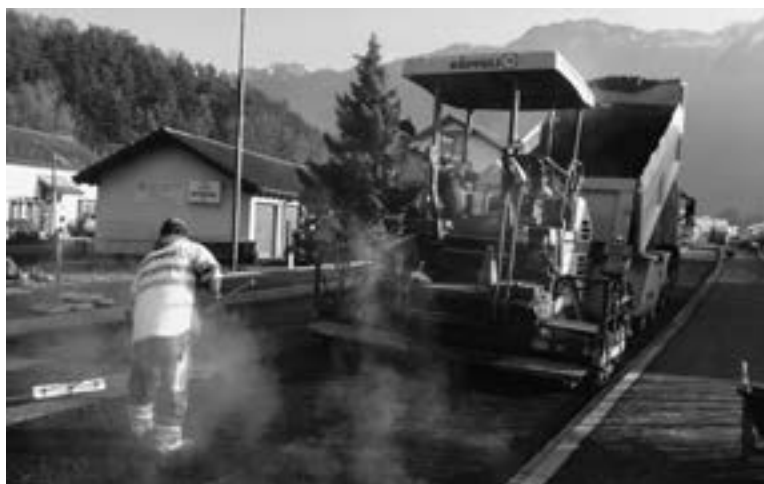
Belagseinbau Kantonsstrasse, Weite
