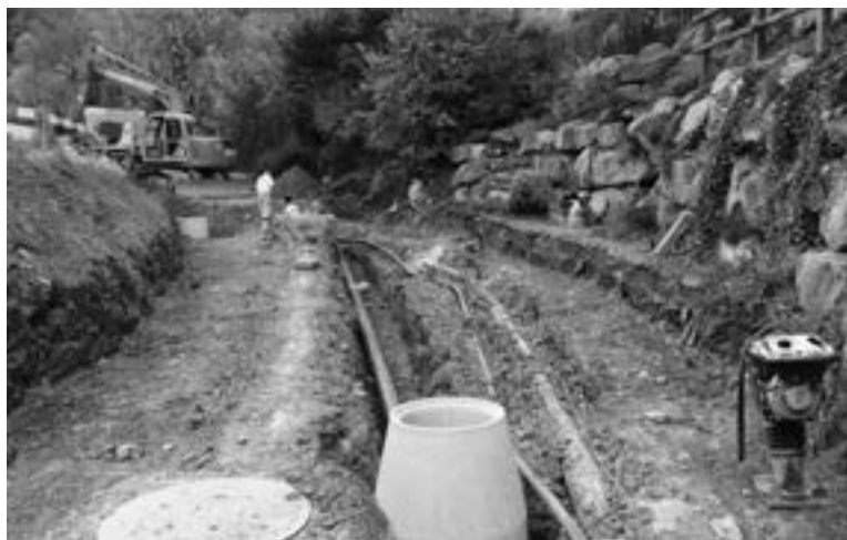
Werkleitungsbau Schollberggasse, Azmoos
